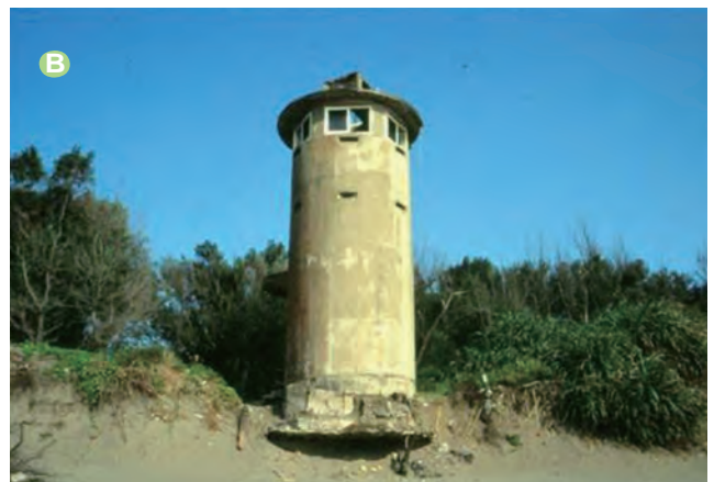
2004年5月時新屋溪口北側海岸因大潭火力發電廠興建突堤效應影響，海岸受到侵蝕後退，與A圖比較，眺望臺前方的沙丘及防風林已經消失（2004.05.25拍攝）。
