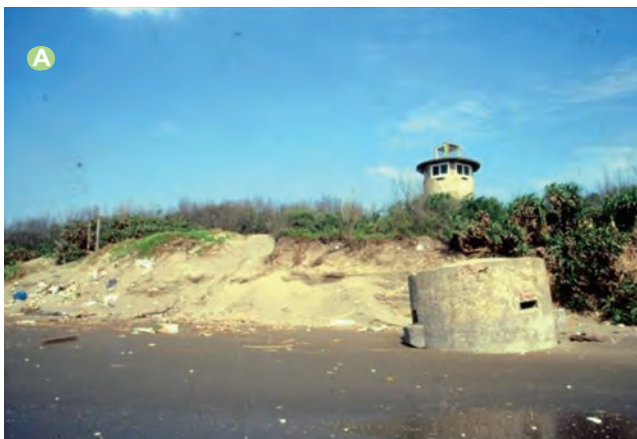
2000年時新屋溪口北側海岸後退，碉堡陷落沙灘中，但海防眺望臺仍在沙丘後方及防風林中（2000.05.07拍攝）。
