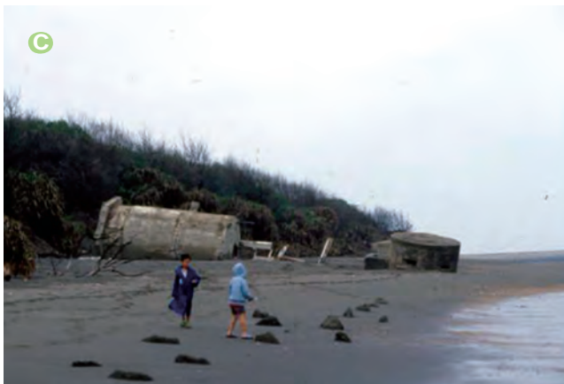
■ 2004年10月颱風過後，海岸繼續侵蝕後退，海防眺望臺已倒塌（2004.10.08拍攝）。
